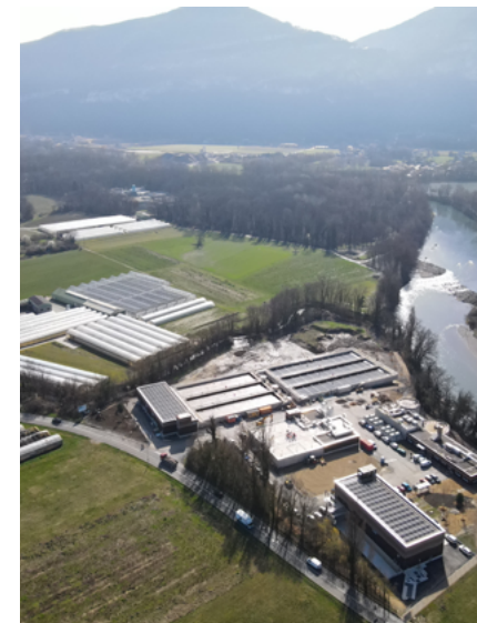
Station d'épuration de Villette
