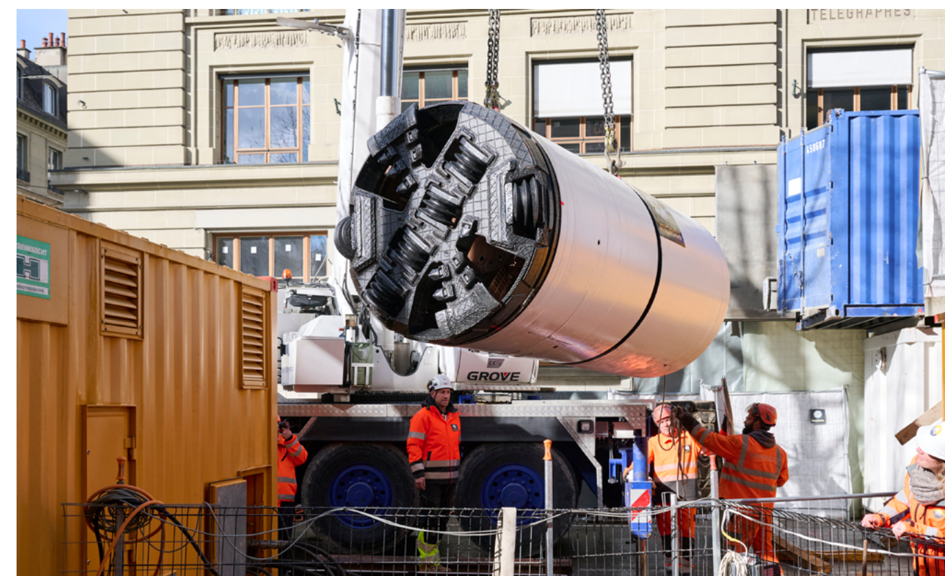
Microtunnelier au Quai de la Poste
