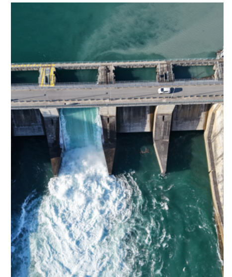
Barrage de Verbois
