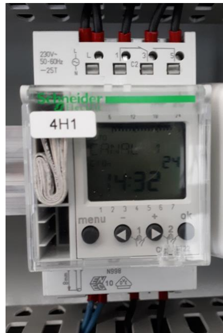
Figure 2 : Exemples d'horloges de commande pour le pilotage des ventilateurs existants en fonction d'horaires prédéfinis.
