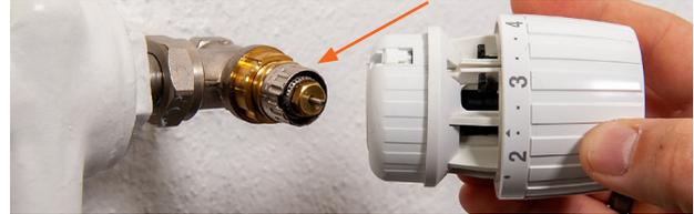
Exemple d'une tige de valve bloquée (voir flèche), qui peut être débloquée en douceur à l'aide d'un maillet en caoutchouc. La tige ne doit en aucun cas être retirée manuellement.
